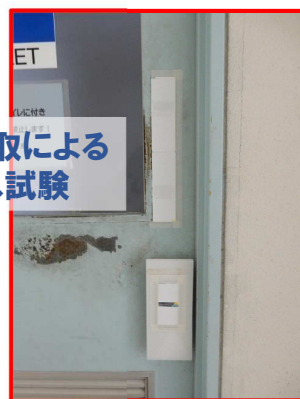
オーバーコート塗布した試験体を設置
