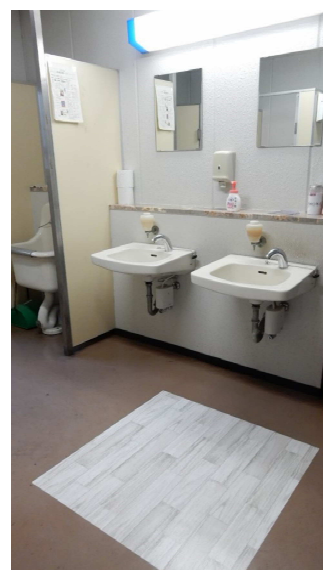
クリアー塗装した床シートを設置
