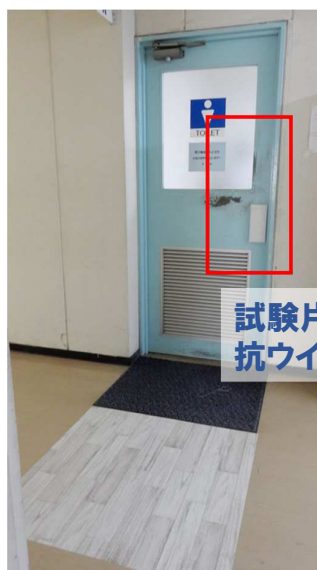
クリアー塗装した床シートを設置
