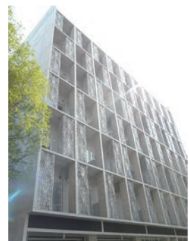
東京大学アントレプレナープラザ
